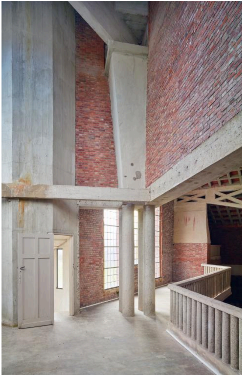
Élément de charpente depuis la tribune.
