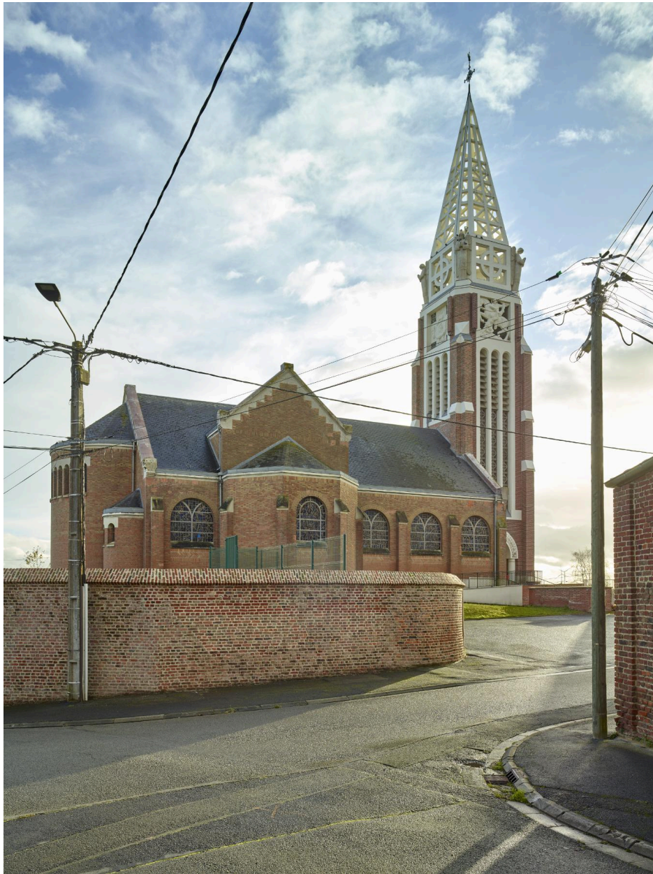
Vue générale de l'église avec le clocher-porche et le mur nord. Vue orientée est-ouest.
