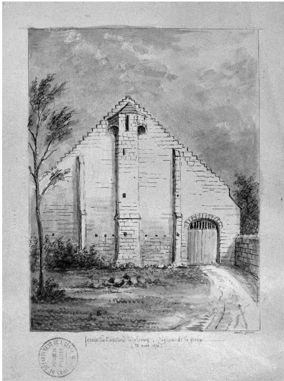
Le pignon nord-ouest de la grange, dessiné le 28 août 1871 par Amédée Piette (AD Aisne : 8 Fi Soucy 4).
