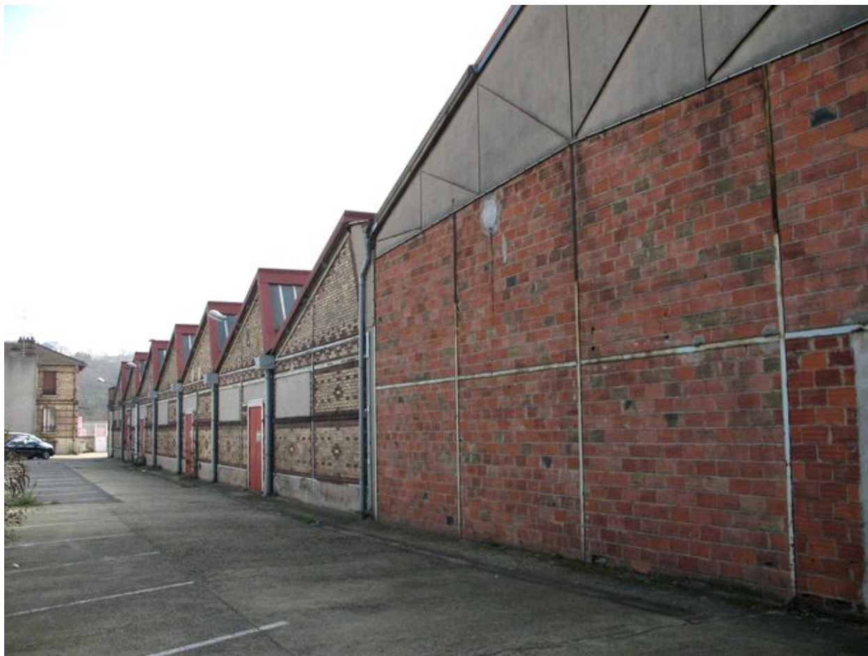
Elevation des ateliers vers le sud.
