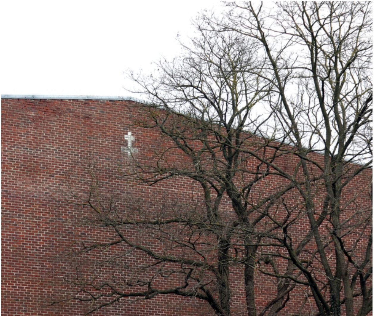
Détail du pignon sud de la halle de 1966.
