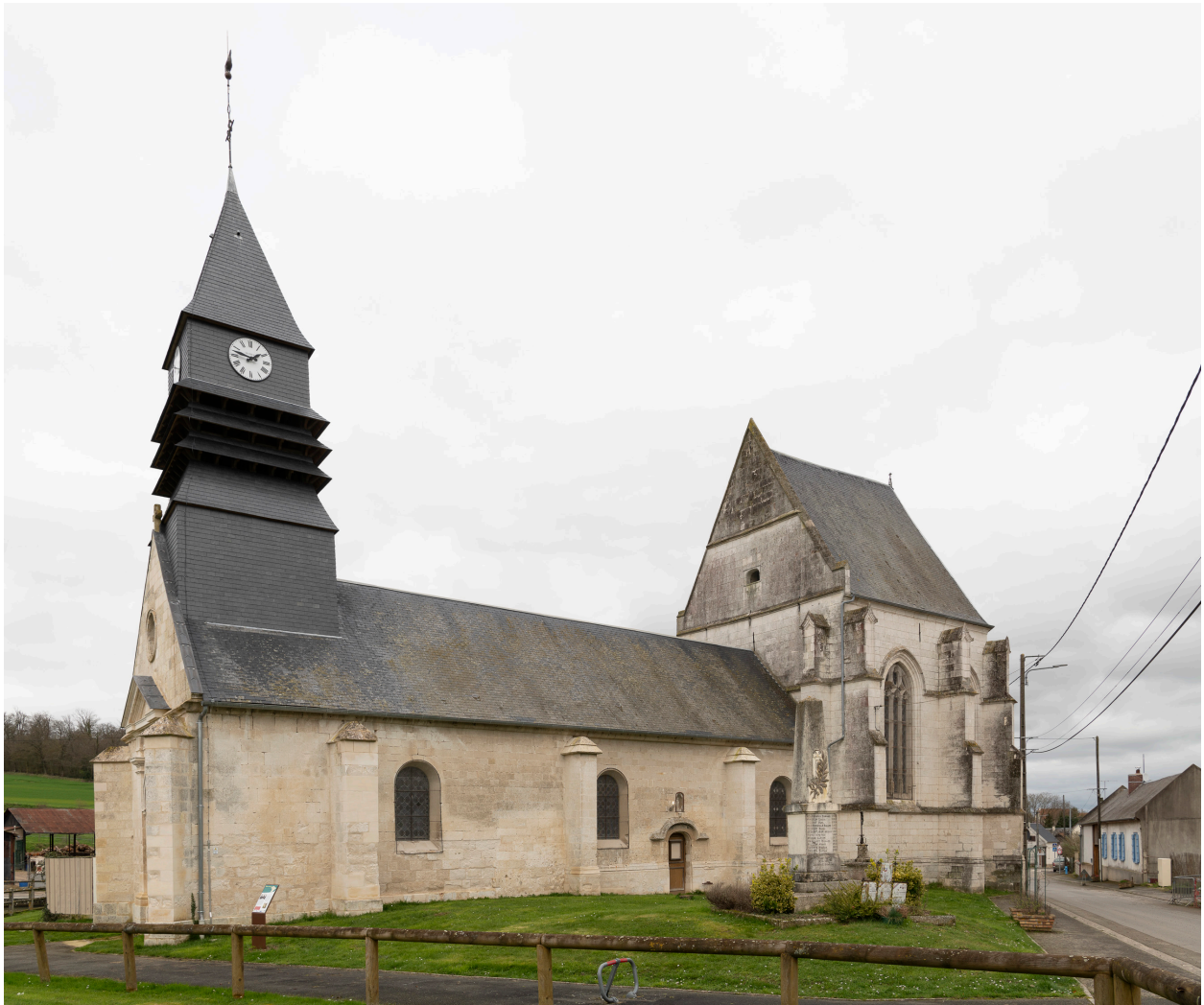
Vue générale depuis le sud-ouest.
