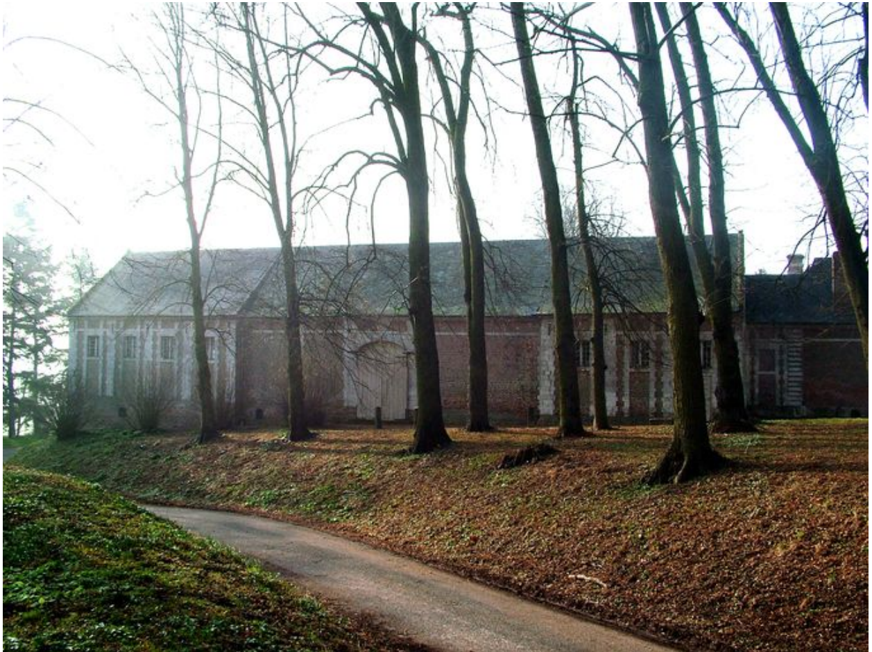
Vue extérieure du bâtiment d'exploitation.
