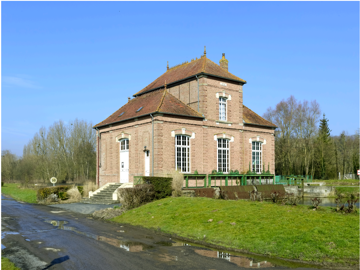
Vue de la centrale, depuis le sud-ouest.
