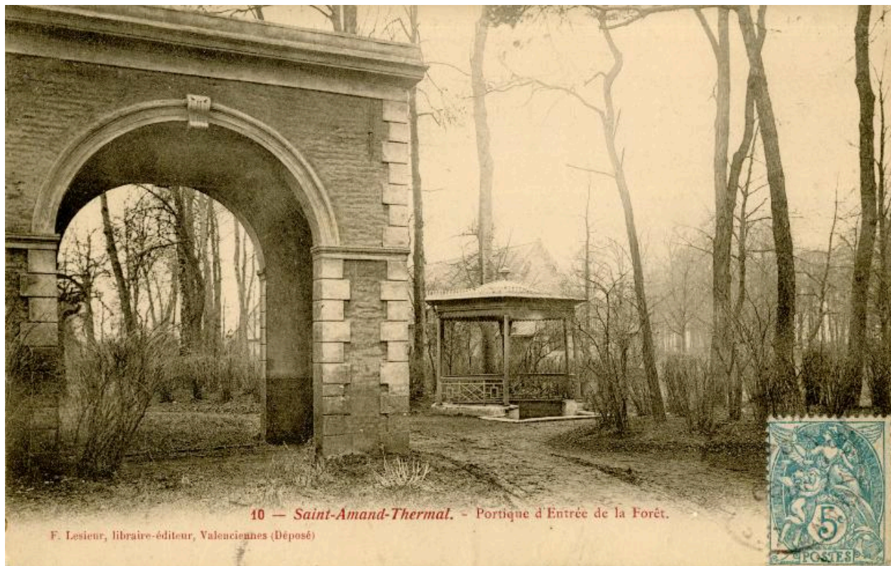
Portique d'entrée de la forêt, carte postale (Médiathèque Saint-Amand-les-Eaux).
