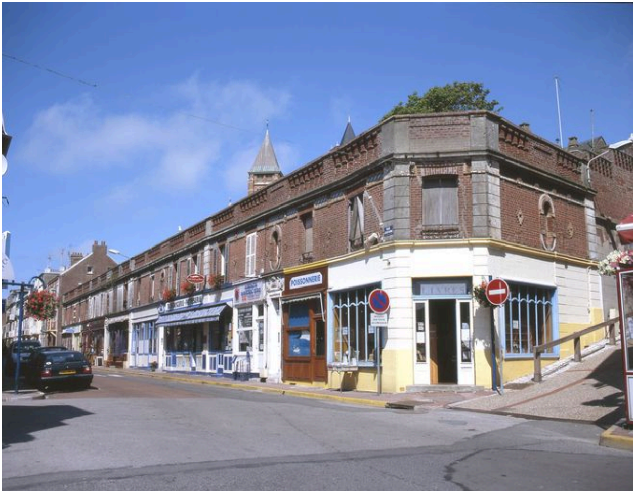
Vue d'ensemble depuis la place Lefort.
