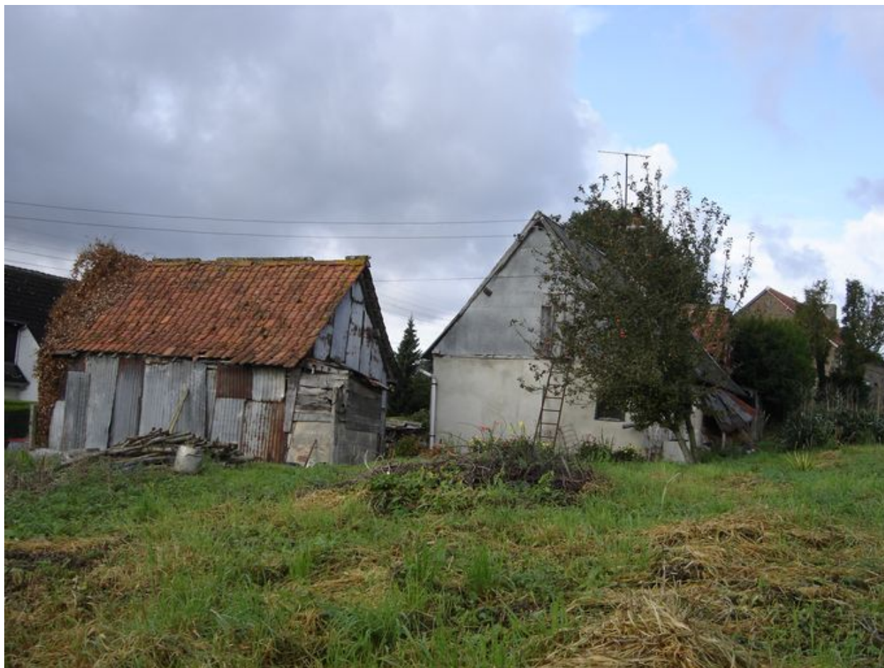
Vue générale postérieure depuis la pâture.
