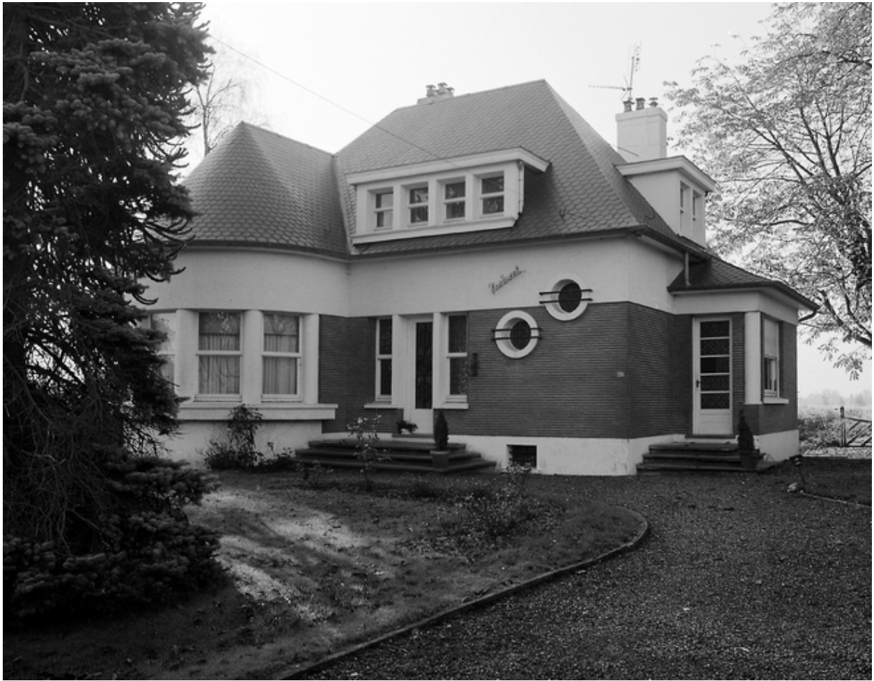
Vue générale, 218 rue Richon.
