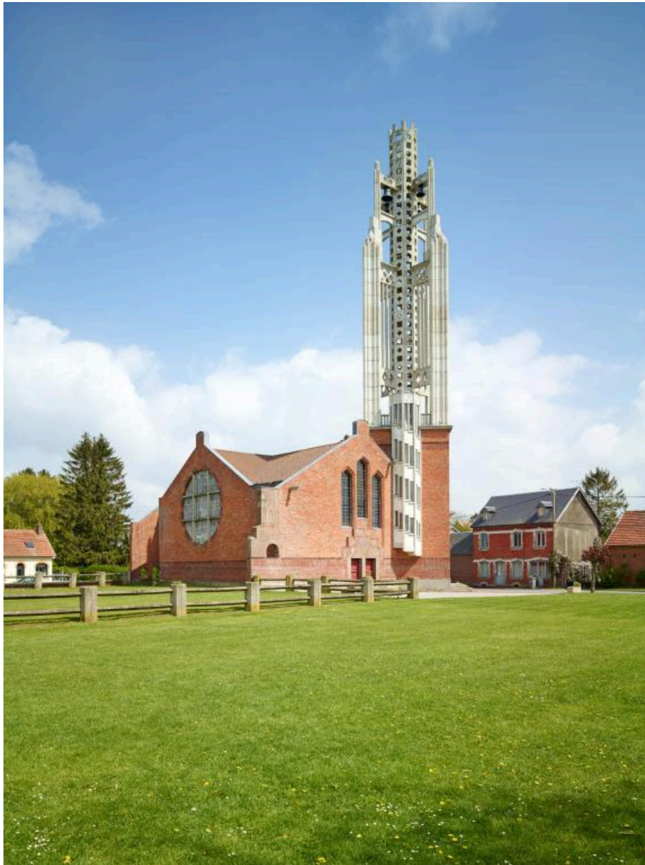
Vue de trois quarts vers le sud-est.
