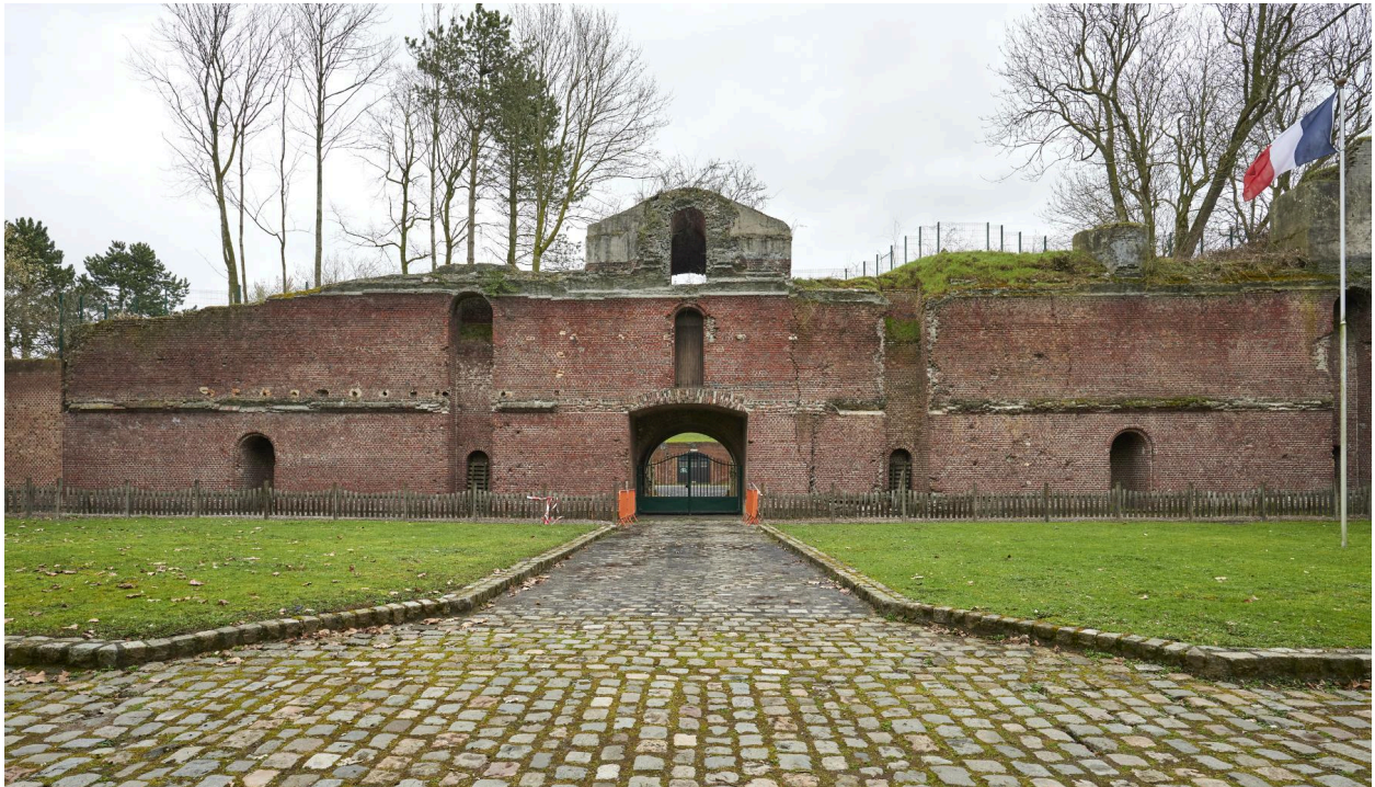
Murs de l'ancienne caserne centrale (disparue) vers le nord-nord-ouest.
