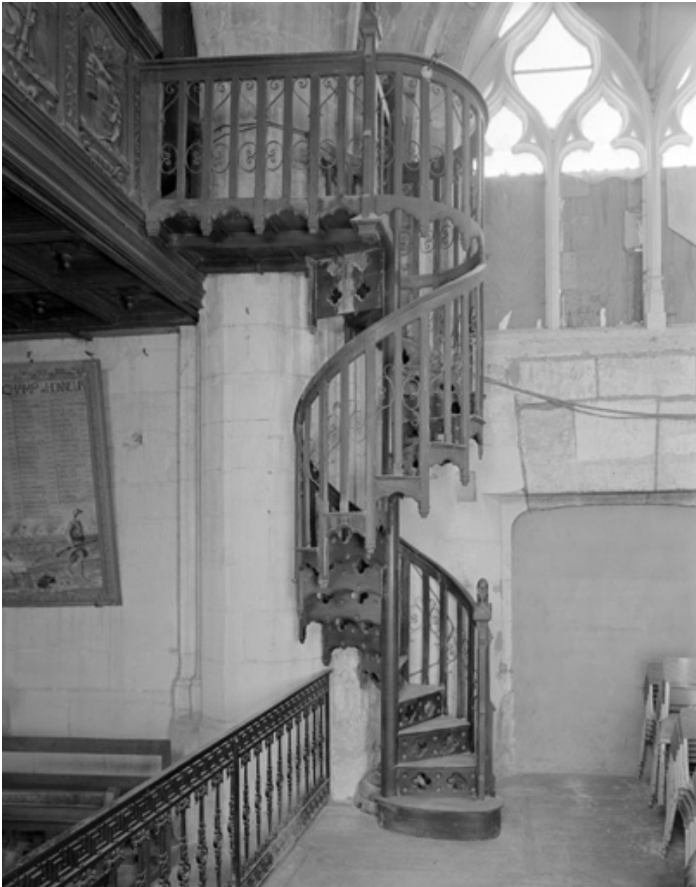
Escalier livré par la maison Haussaire, métal et bois, 19e siècle, vue d'ensemble.
