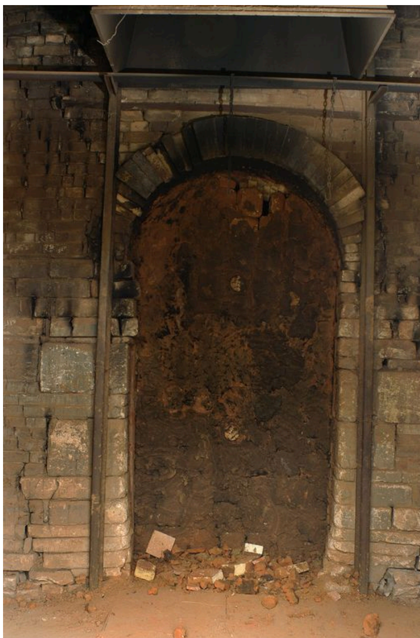
Entrée obturée du four de cuisson avant son allumage.
