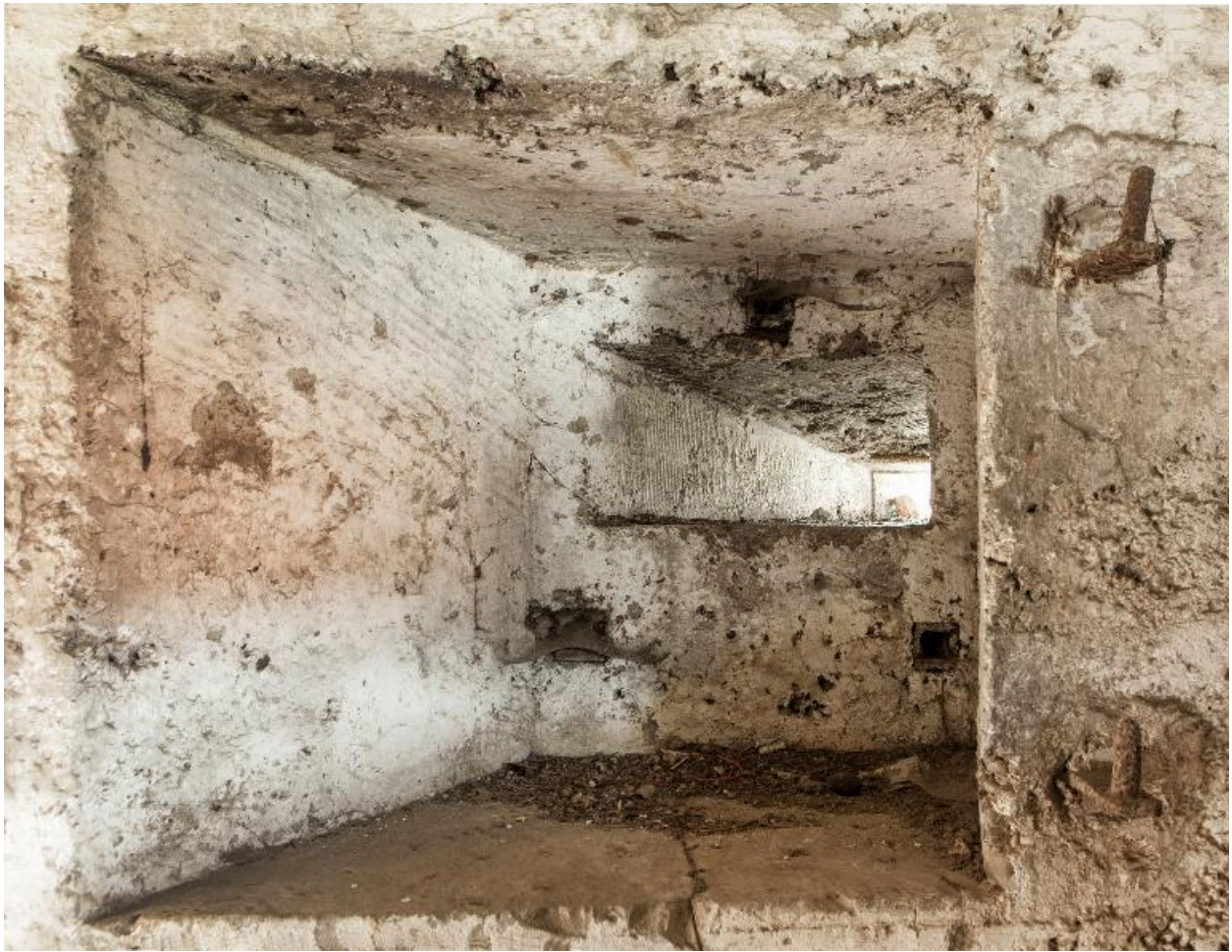
Rez-de-Chaussée. Créneau de fusillade protégeant l'entrée
