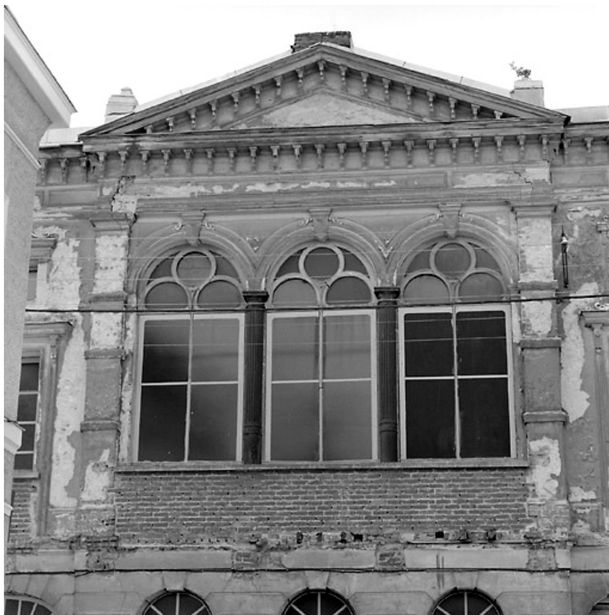
Façade, avant-corps, 1er étage, état en 2005.
