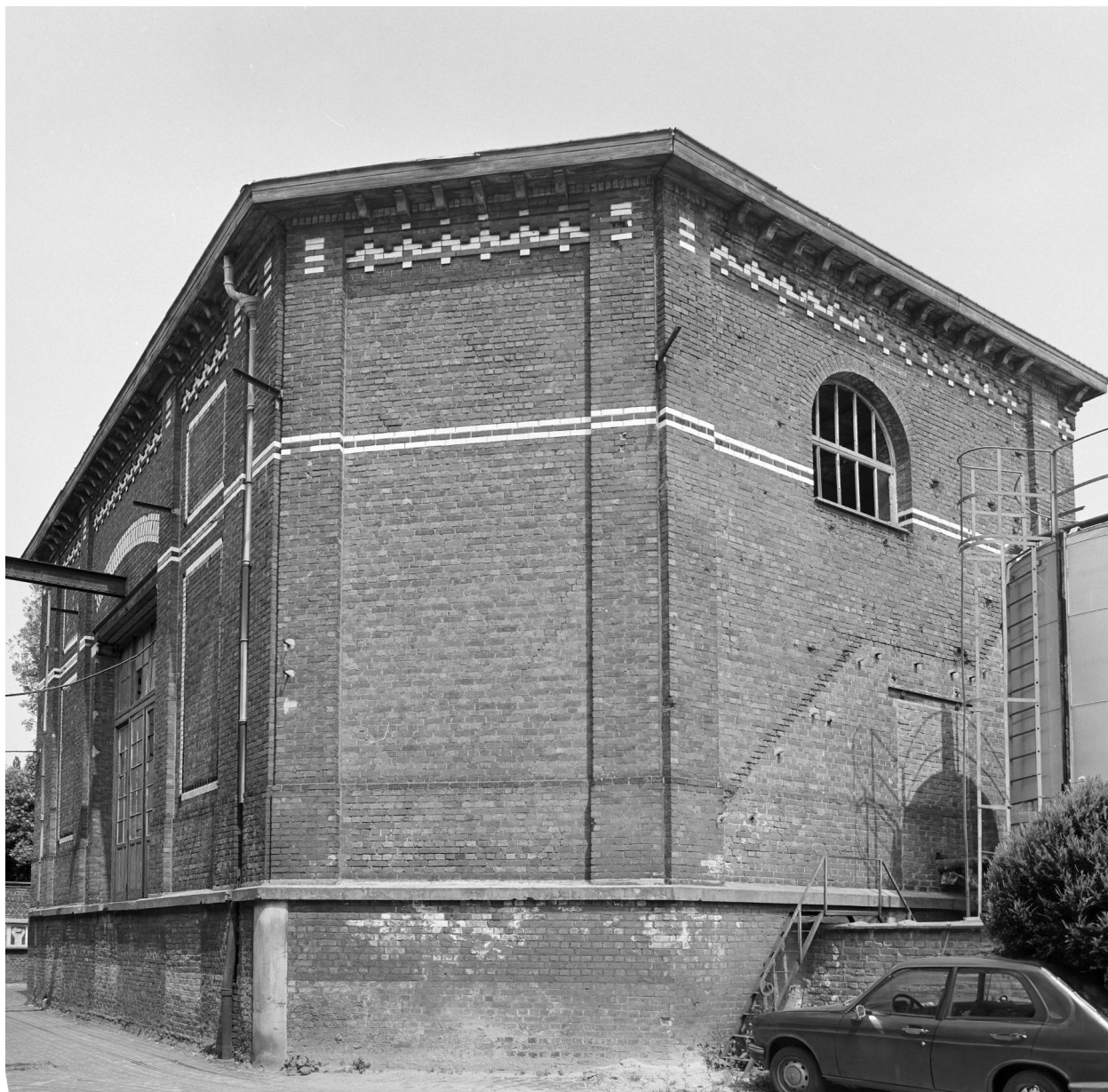
Ancienne salle des machines. Élévation postérieure.
