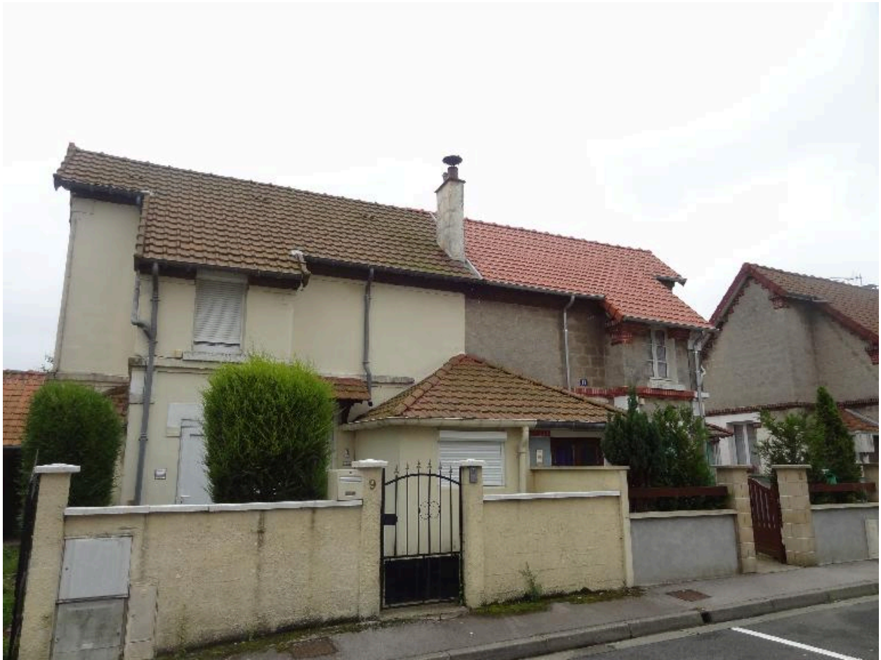
Immeuble à logements locatifs : façade de deux logements.
