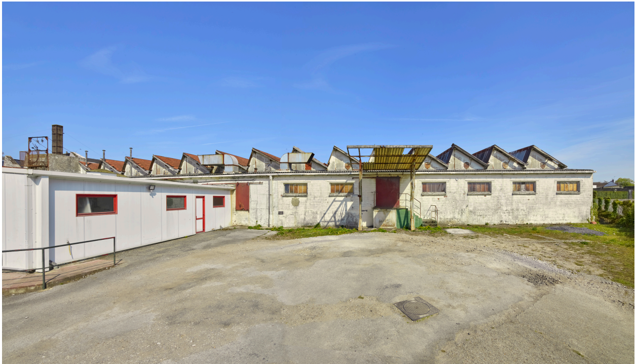
Vue du bâtiment d'usine de 1957, depuis le sud.
