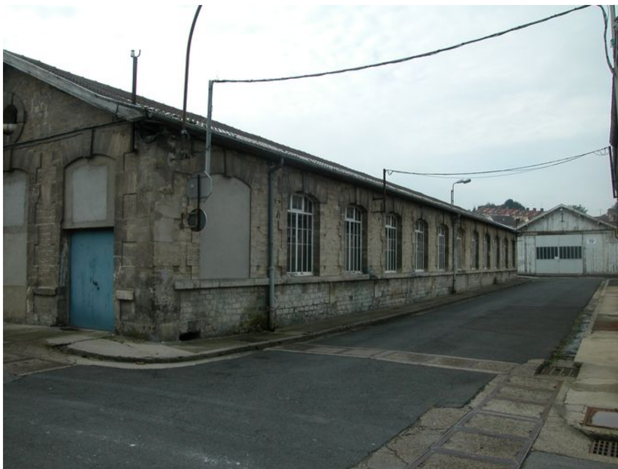
Façade longitudinale d'un des ateliers de fabrication.
