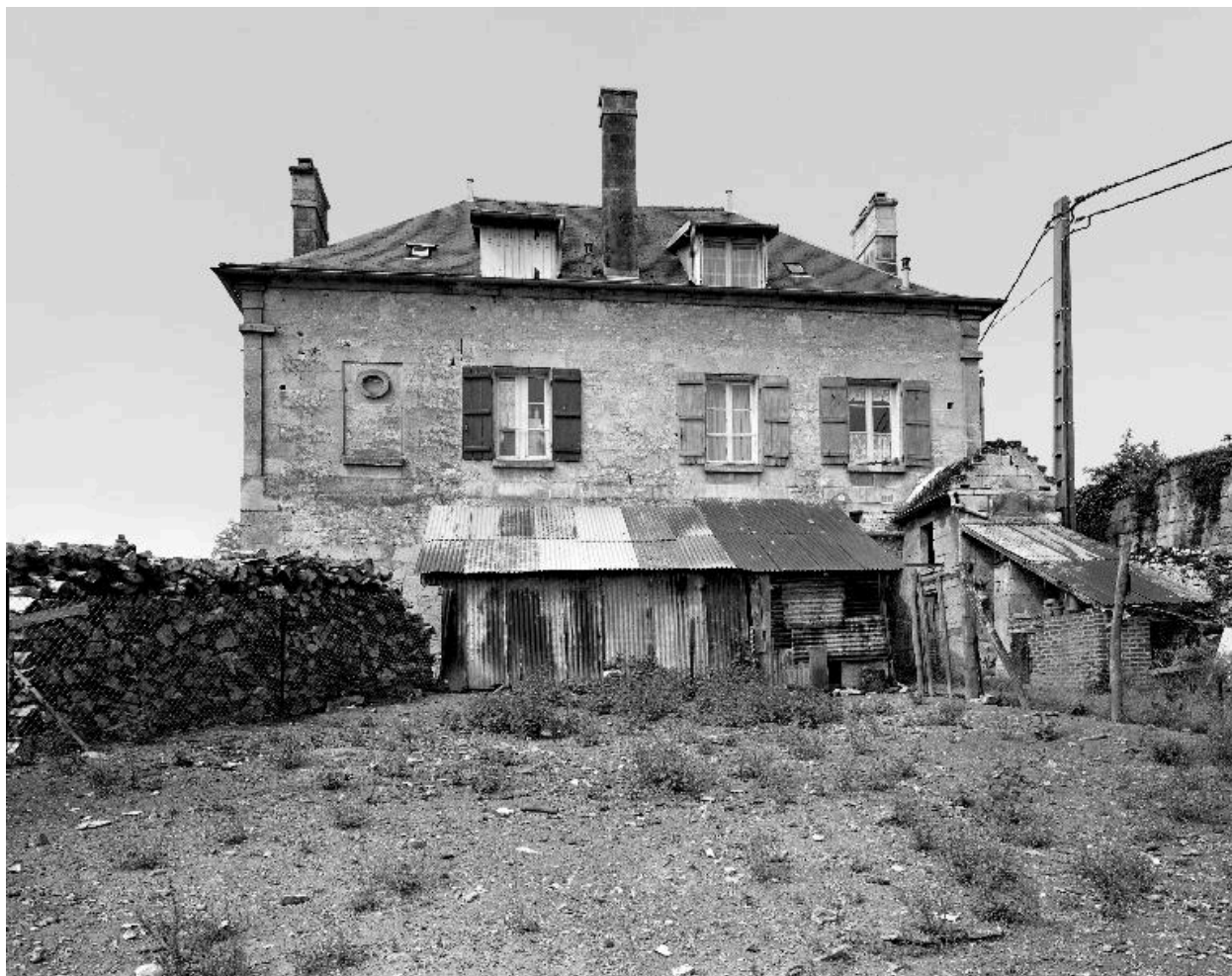
Vue générale de l'élévation arrière (nord-est).
