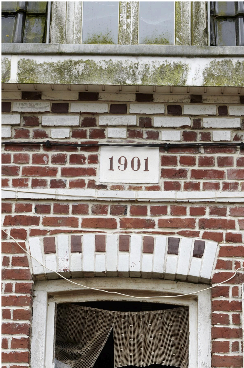
Détail de la date portée "1901" et motifs décoratifs en brique.
