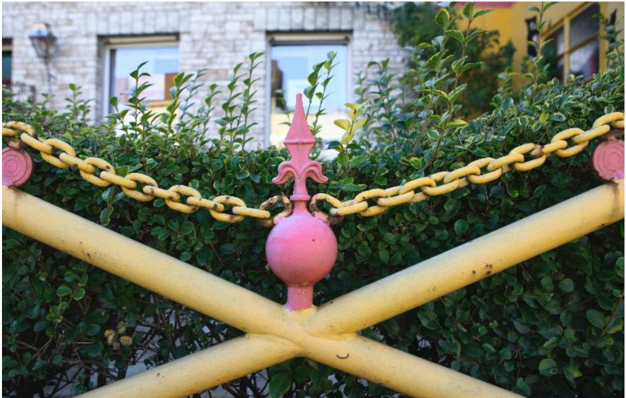
Façade sur rue, détail de la clôture.
