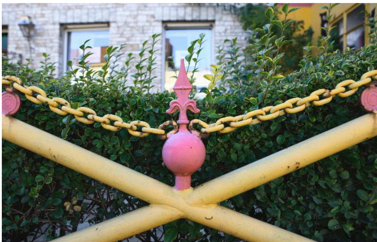
Façade sur rue, détail de la clôture.
