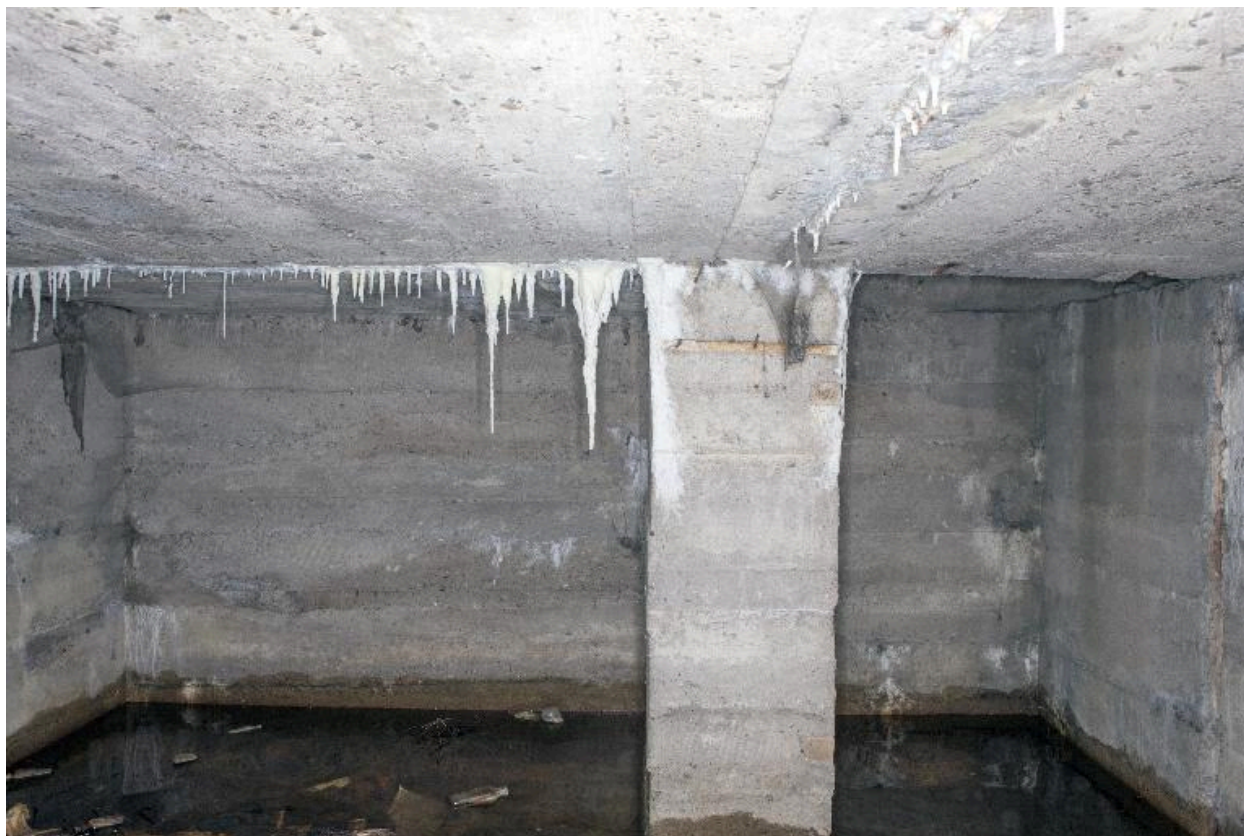
Salle ouest, mur de refend. Accès à l'observatoire, à droite.
