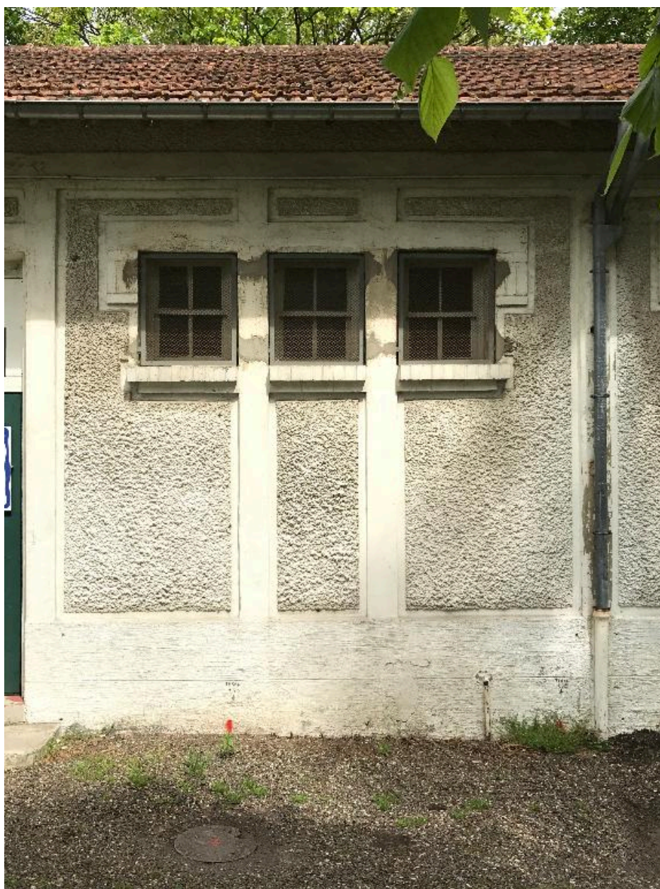
Détail d'une travée.
