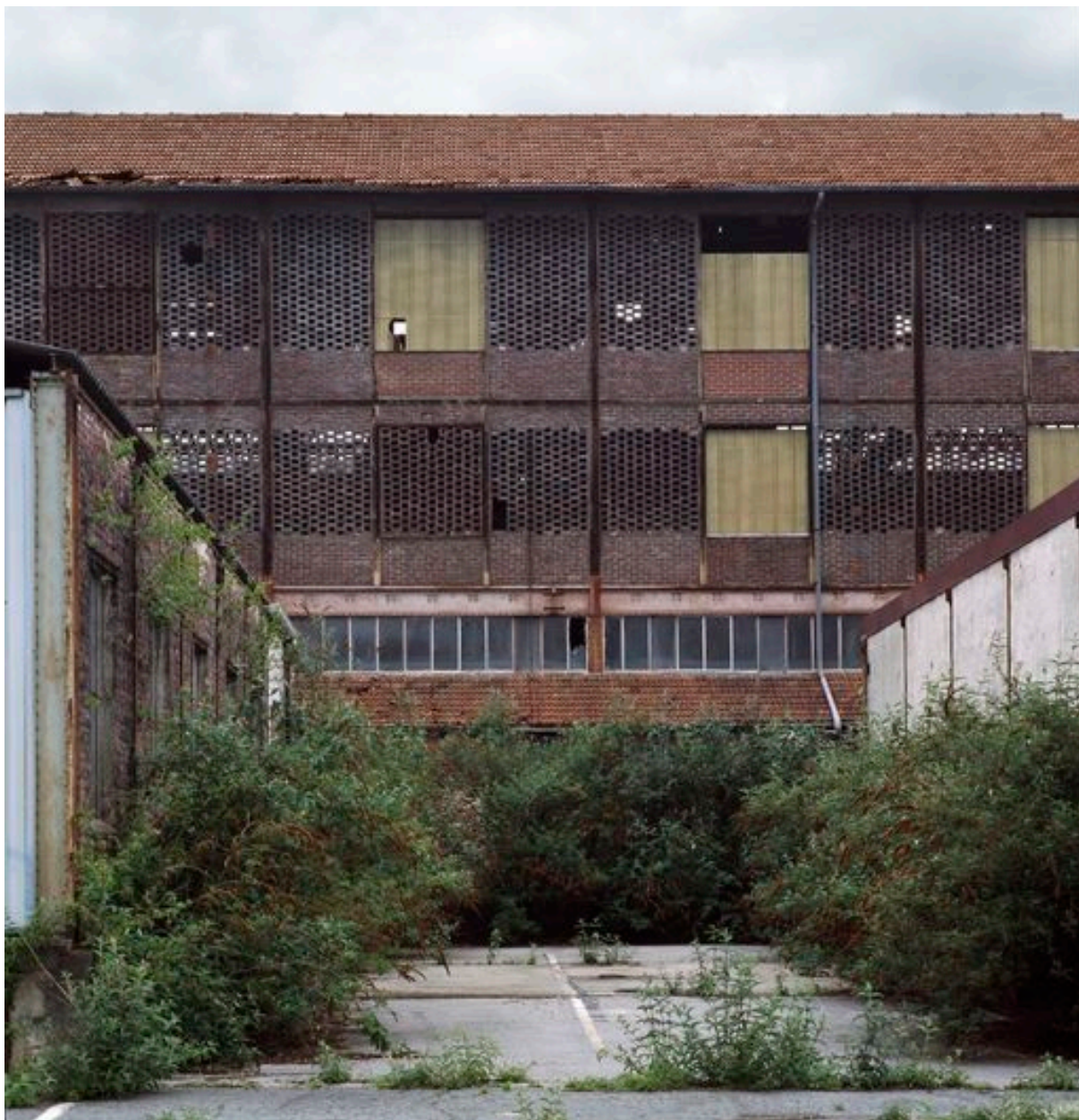
Détail de l'atelier d'embarillage et de sa façade à claire-voie.
