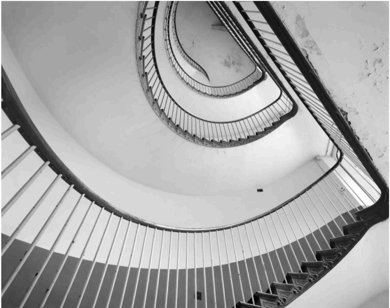
Vue d'une cage d'escalier de l'aile droite.
