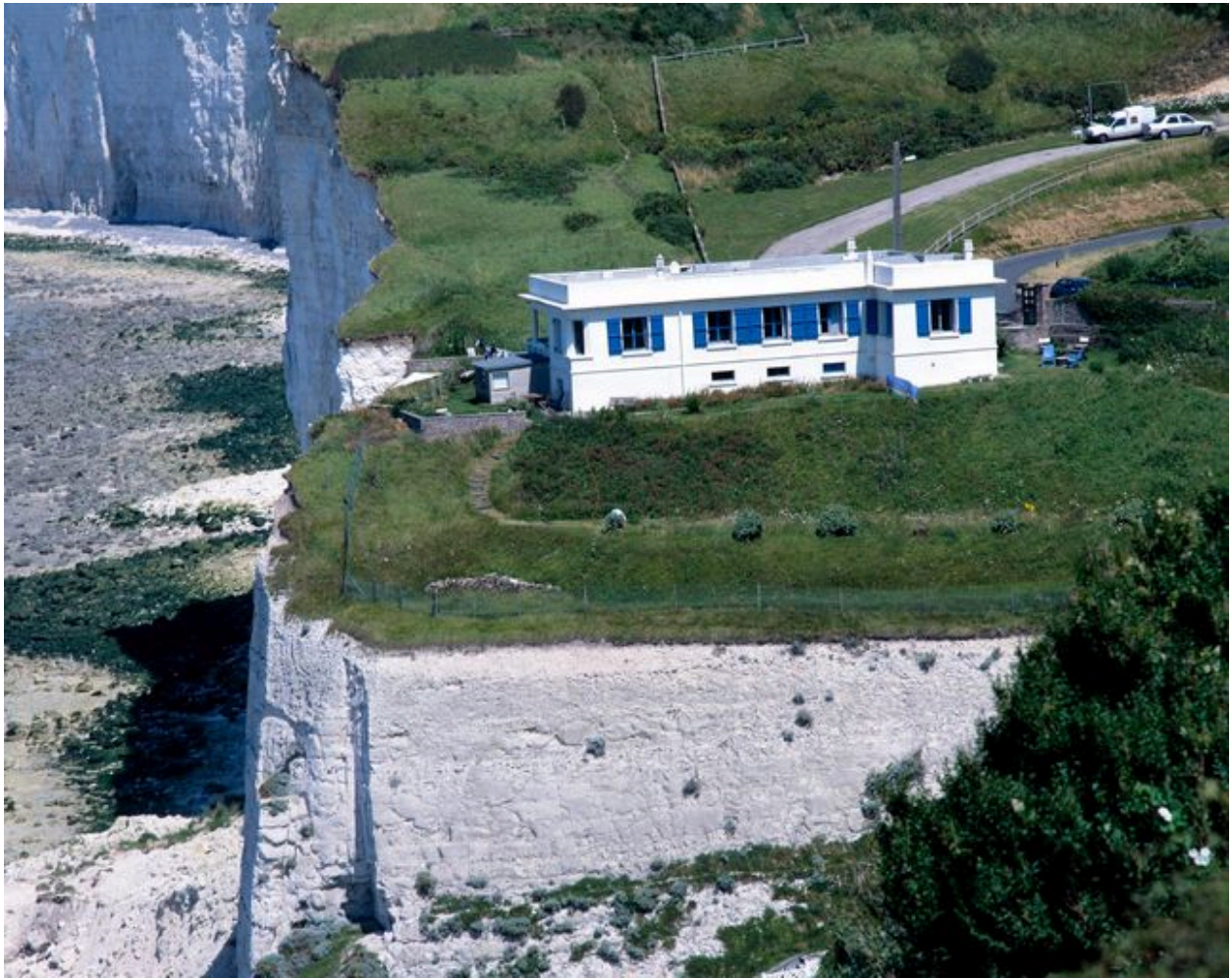
Vue d'ensemble, état actuel.
