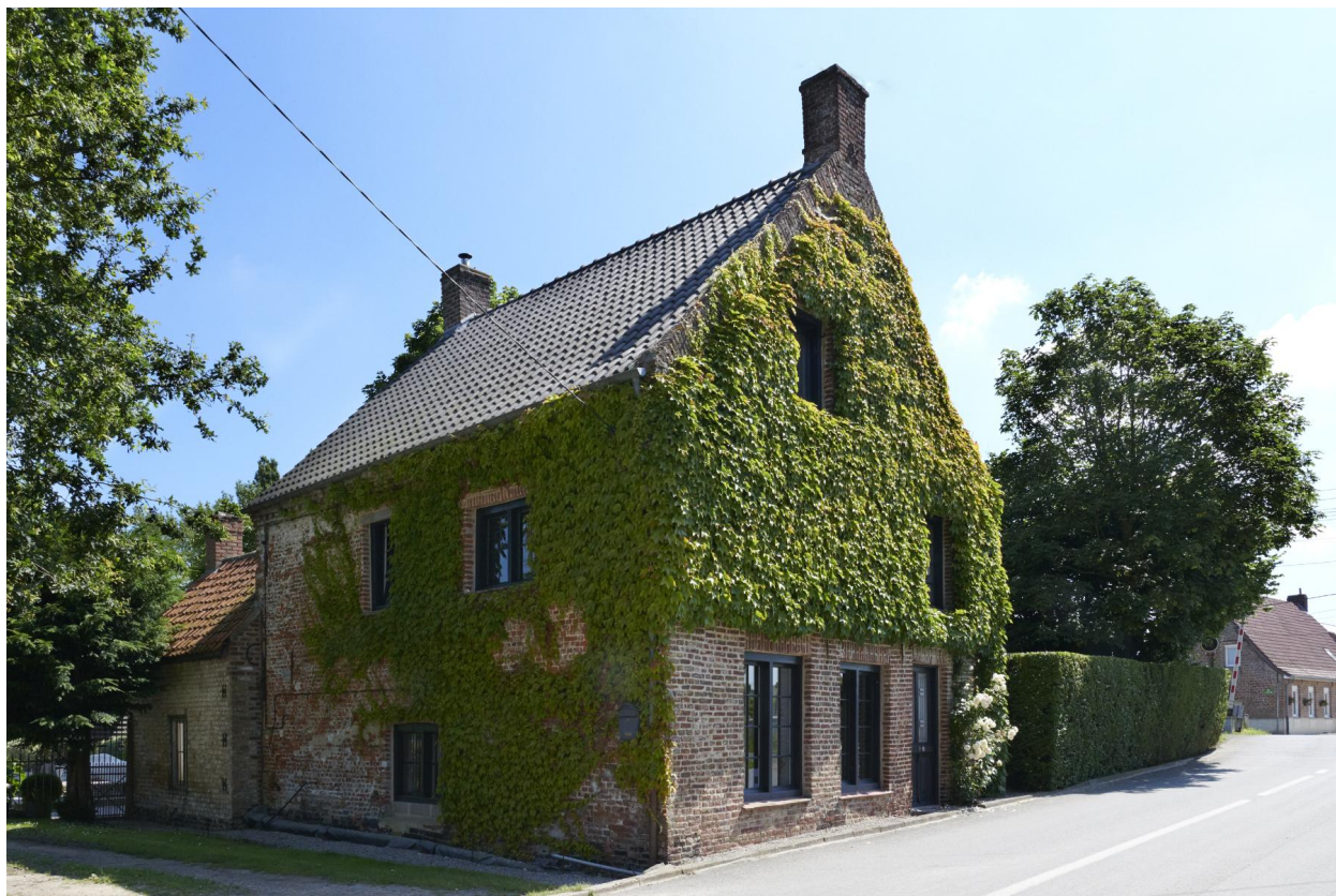
Façade principale et côté gauche.
