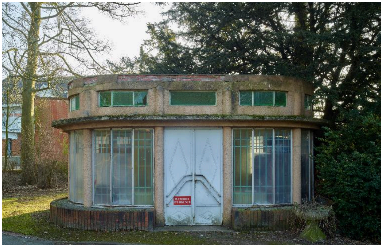
Salle d'attente située près de l'entrée principale de l'établissement, élévation antérieure, vue générale.
