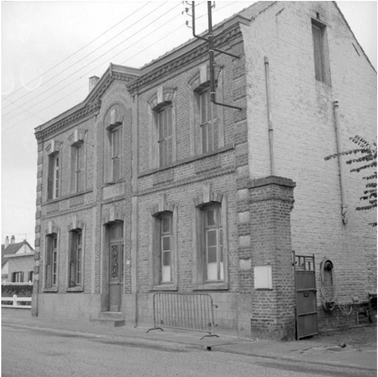
Logement patronal, élévation antérieure.
