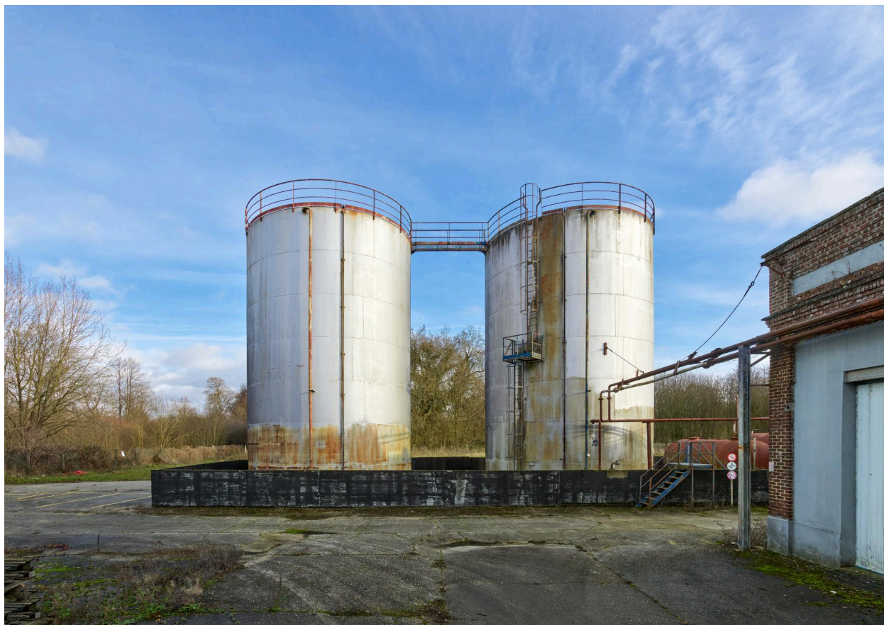
Cuves de stockage entre les bâtiments A et N.
