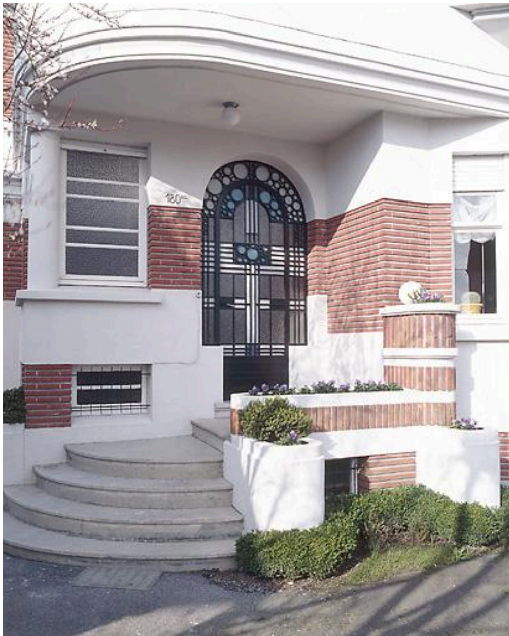
Détail de l'entrée.
