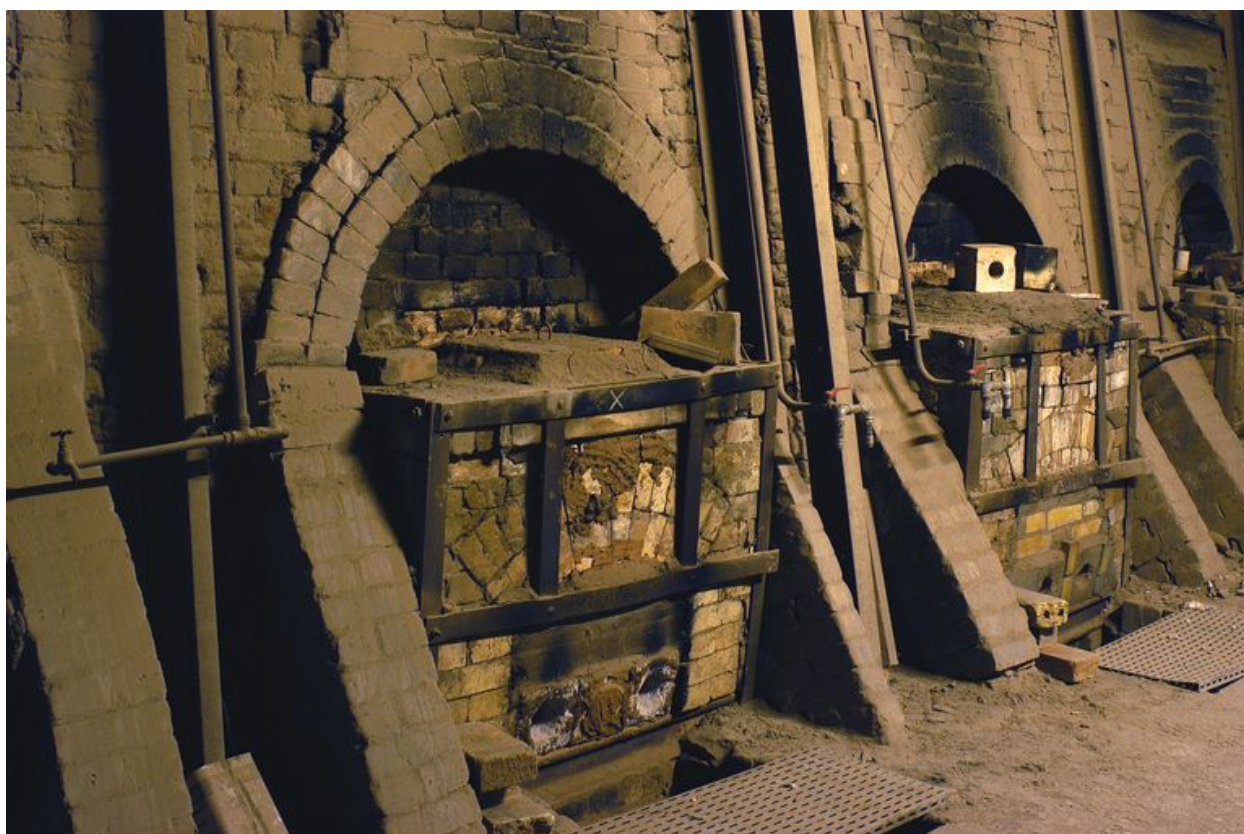
Détail des alandiers du four de cuisson.
