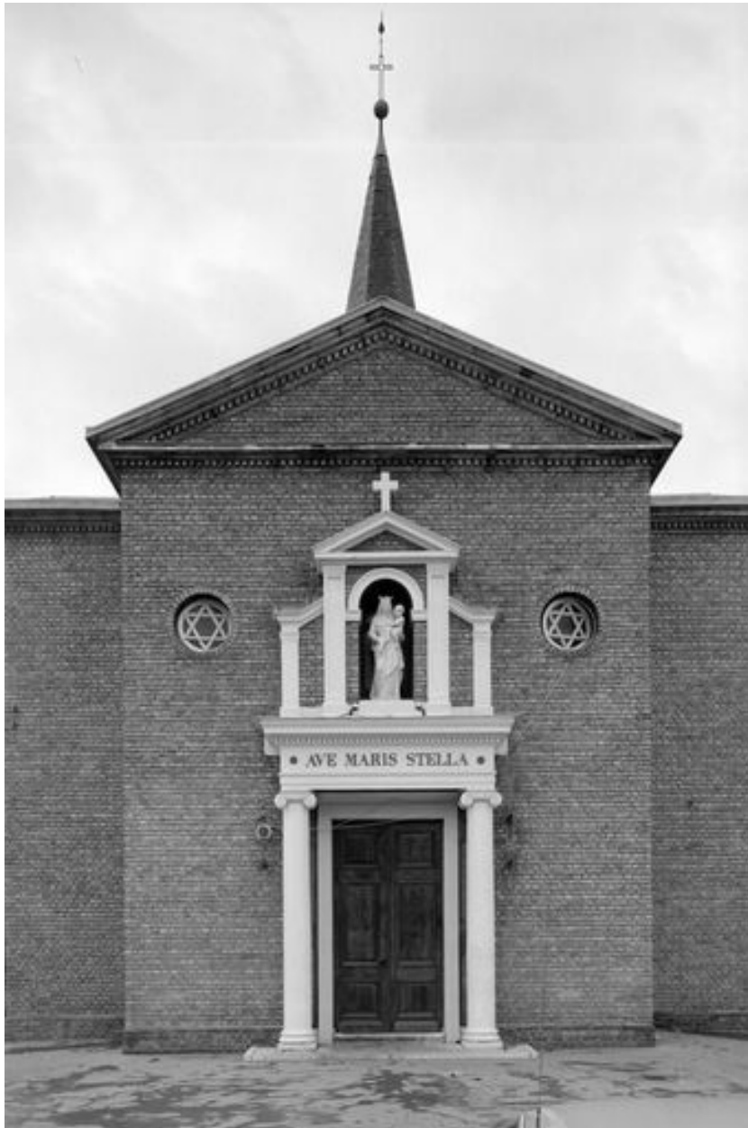
Vue générale de la façade nord.
