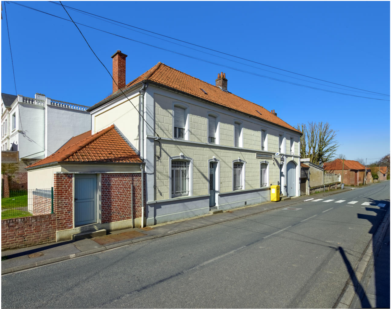
Vue de la façade depuis le sud.
