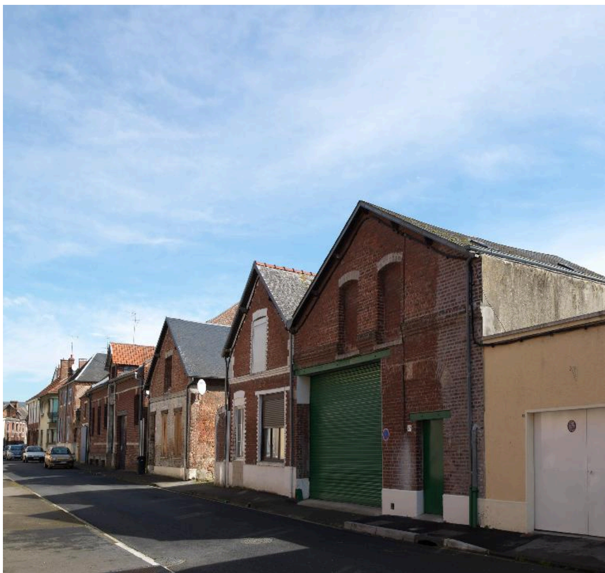
Entrepôts, rue Marchande.
