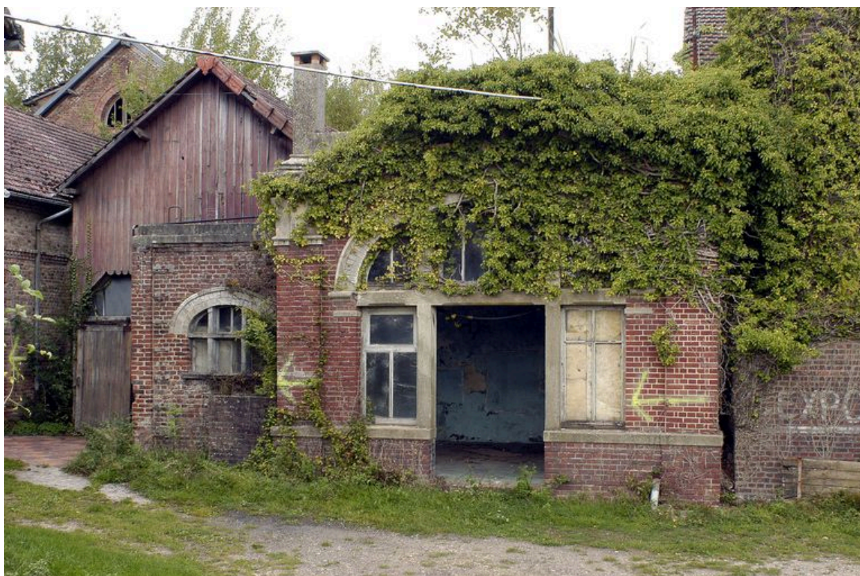
Façade de la salle des machines.
