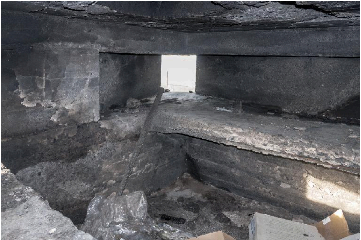
Vue intérieure de la banquette de tir nord et embrasure de tir nord-ouest
