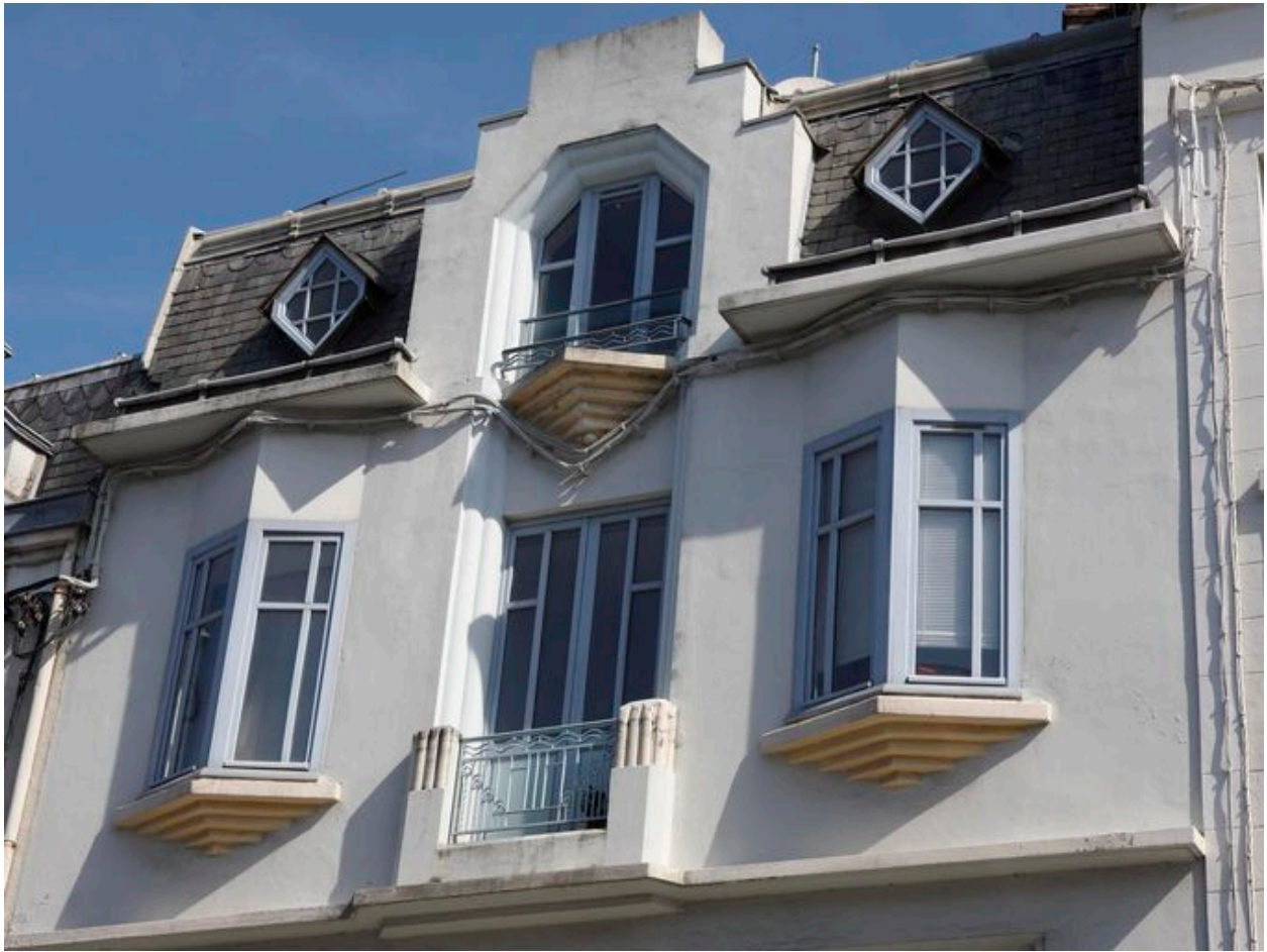
Vue d'ensemble des formes géométriques de la façade.
