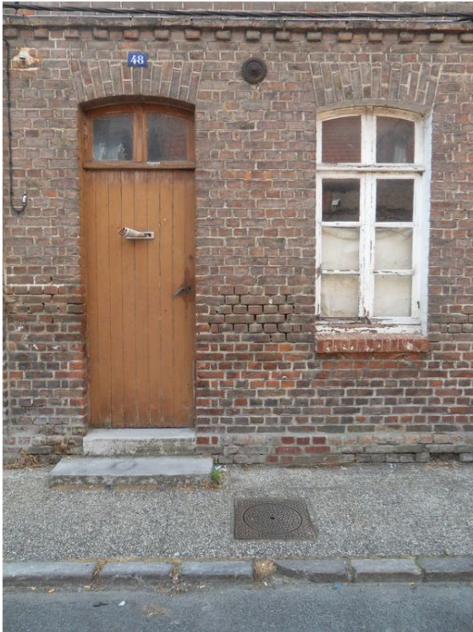
Logement, 48 rue Docteur-Jean-Martin, détail de la façade.
