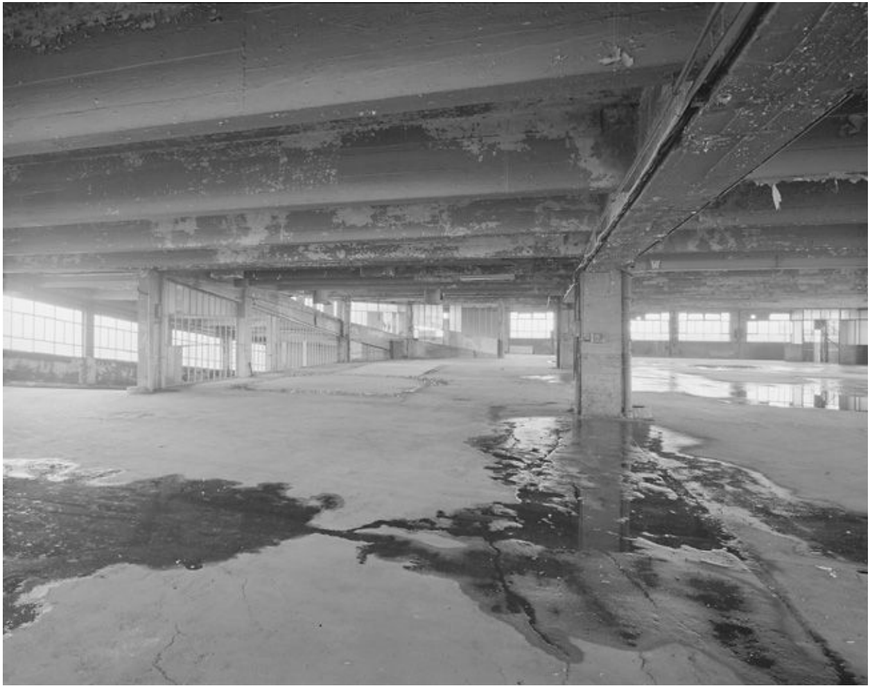
Vue d'ensemble du niveau 3.
