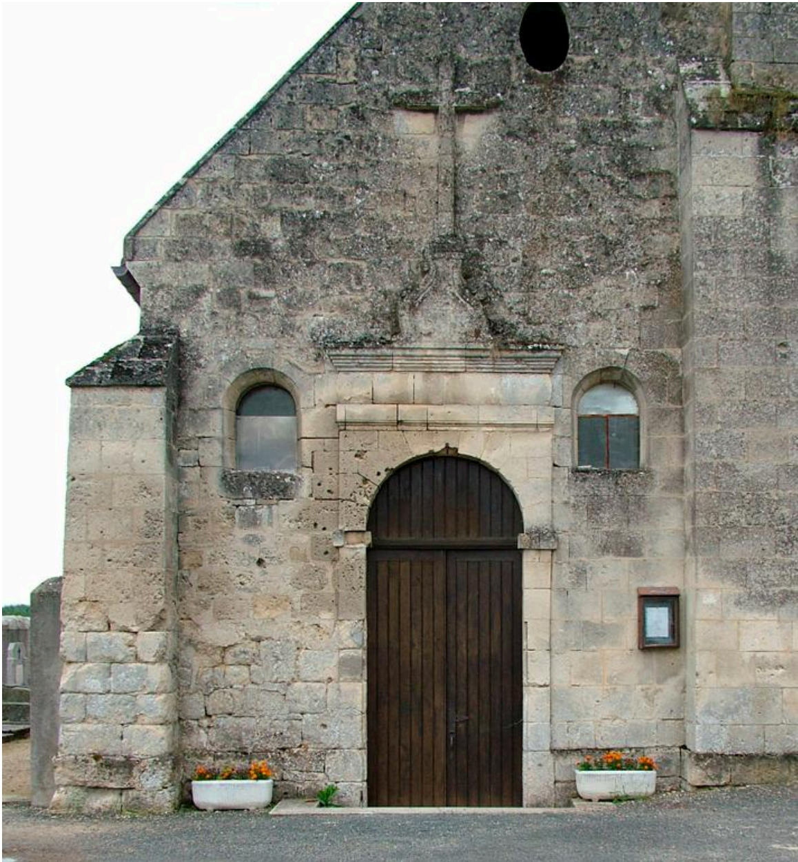
Vue du portail occidental.
