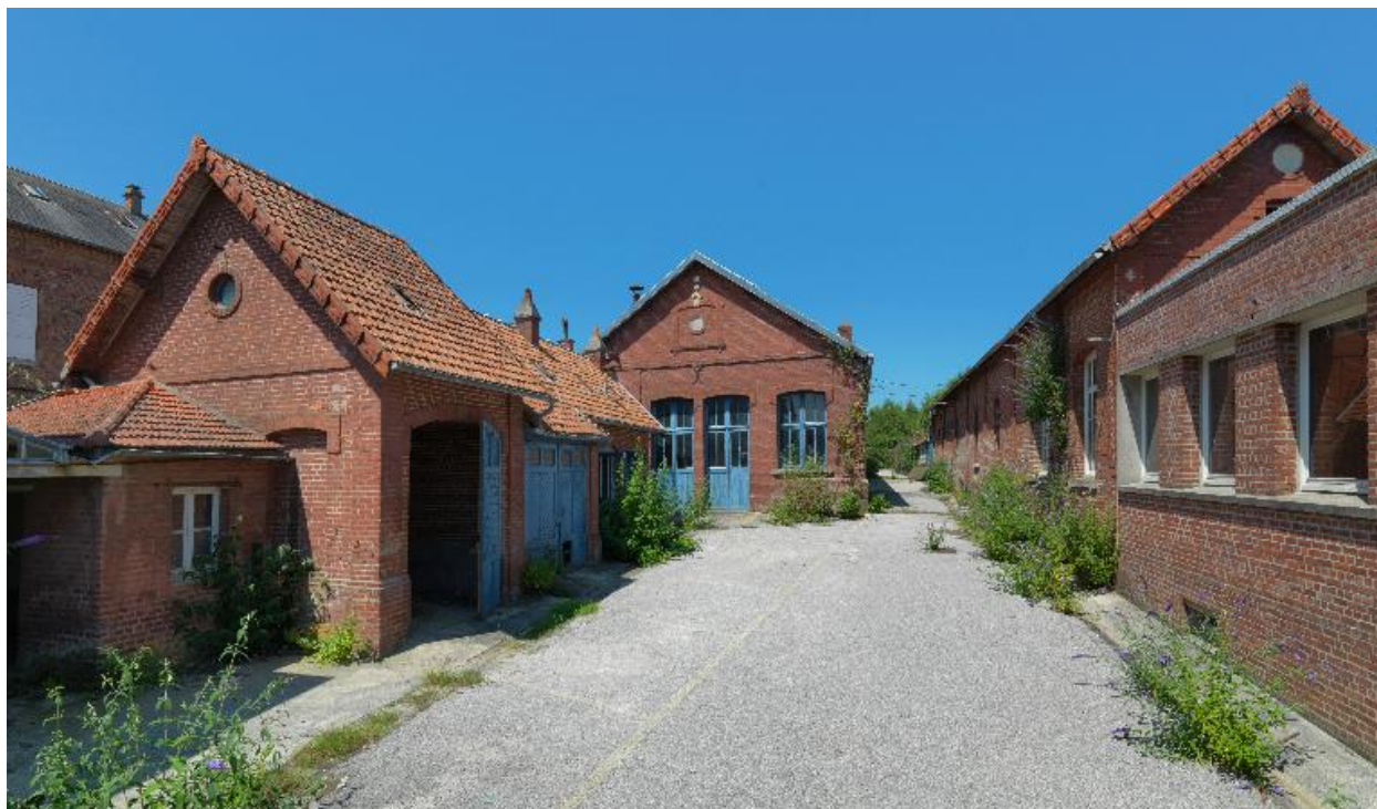
Vue générale depuis la rue Henri-Barbusse.
