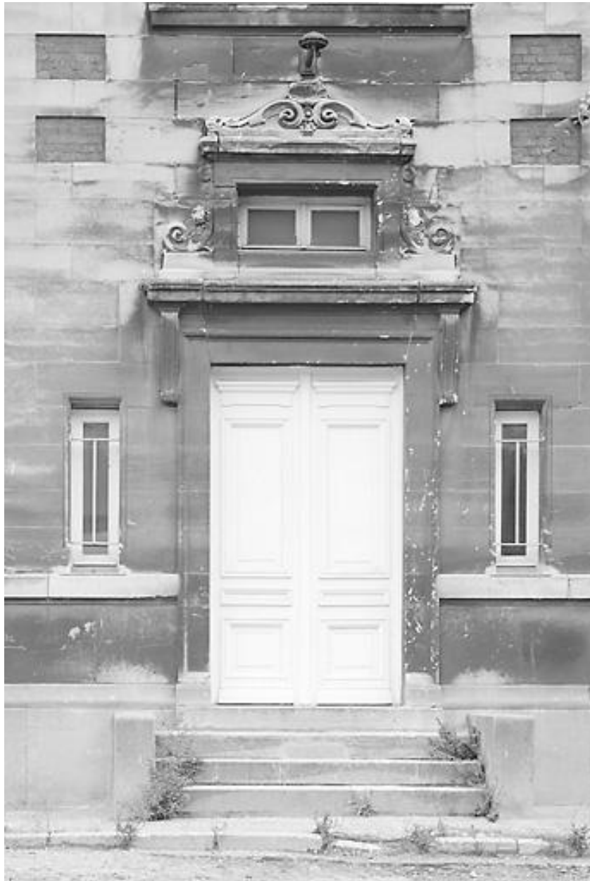
Façade sud-ouest, porte.
