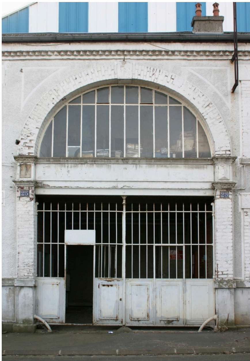
Entrée des ateliers des années 1920.
