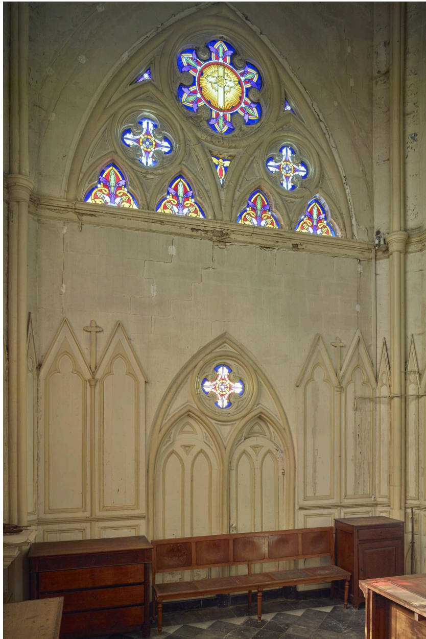
Vue de l'élévation et de la verrière nord est du chœur.
