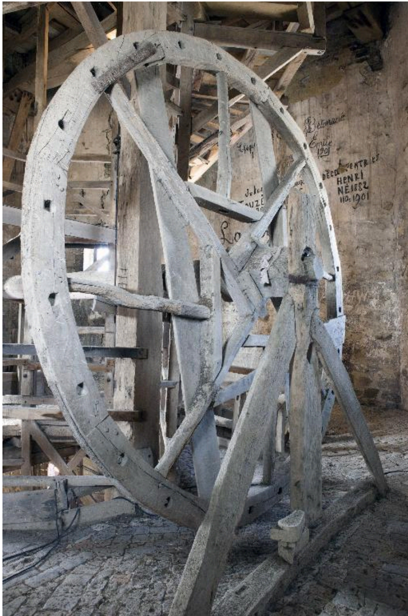
Escalier et roues d'accès au carillon.
